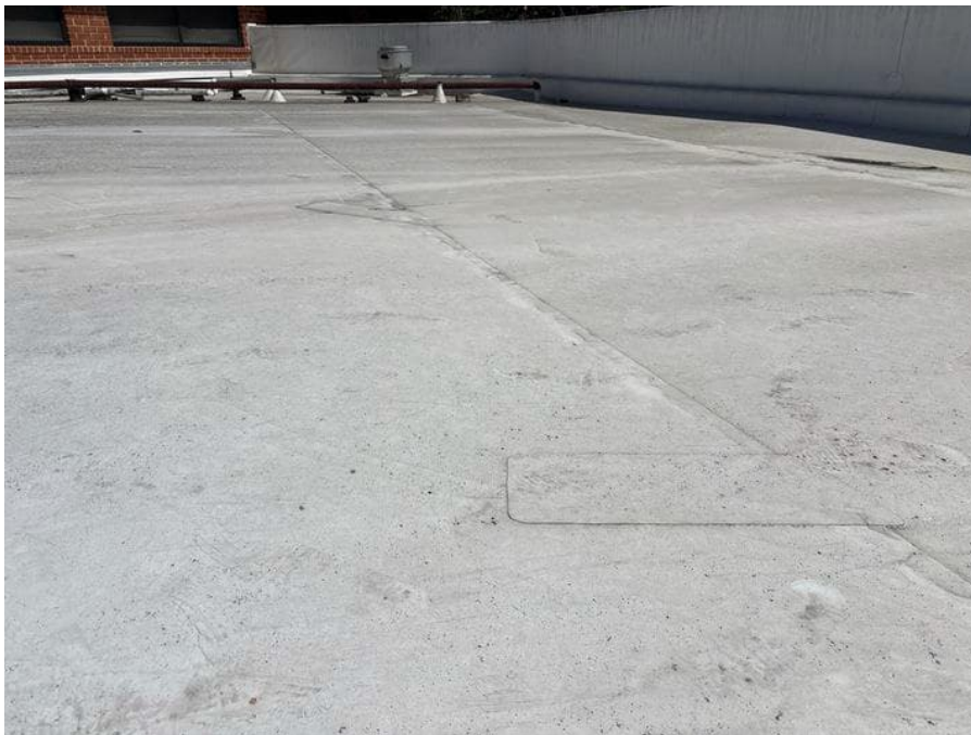
HA 5 - Membrane Roof Core
