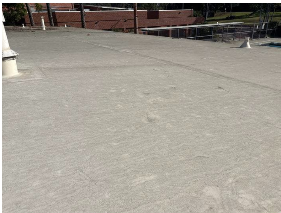
HA 4 - Membrane Roof Core
